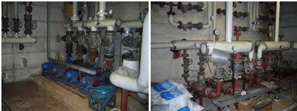
Gruppi di pompaggi sottocentrale termica di Levante
