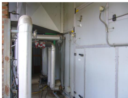
Unità di trattamento aria per Area di Ponente
