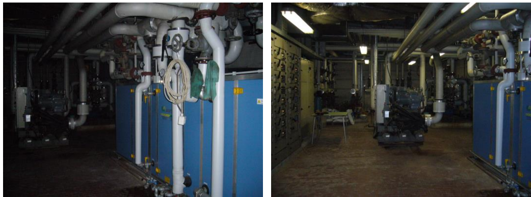
Unità di trattamento aria per zona Levante e Gruppo Frigorifero
