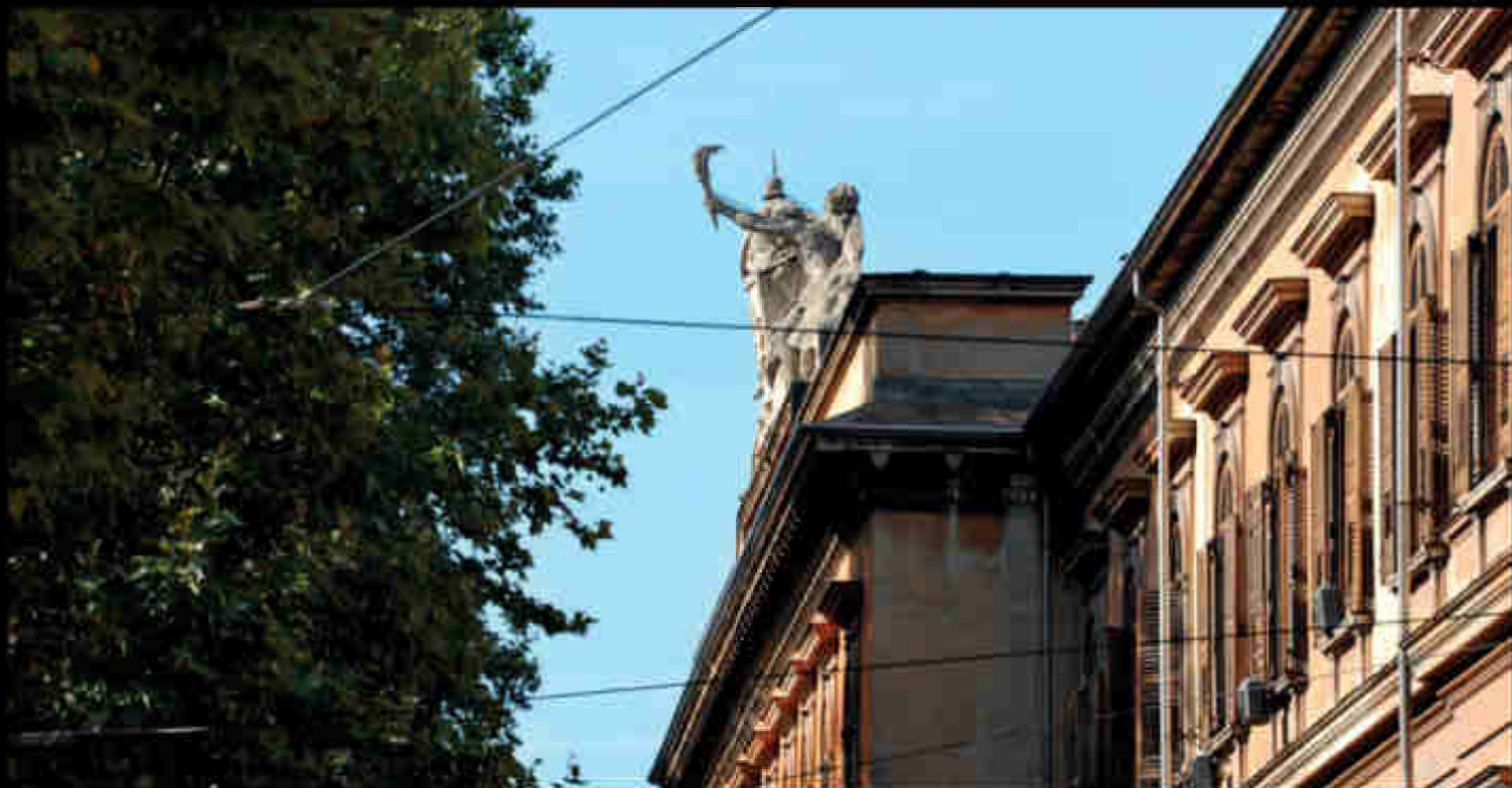
La facciata principale di accesso all'Ospedale Mauriziano Umberto I dal viale di Stupinigi (oggi corso Filippo Turati), prima della realizzazione del nuovo accesso da largo Turati. Alla sommità del corpo centrale aggettante lo stemma mauriziano.
