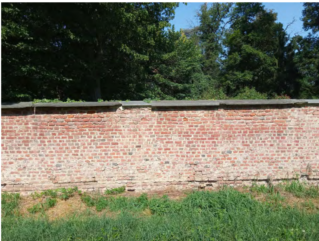
Tipologia 1 – Paramento murario in laterizio originale
