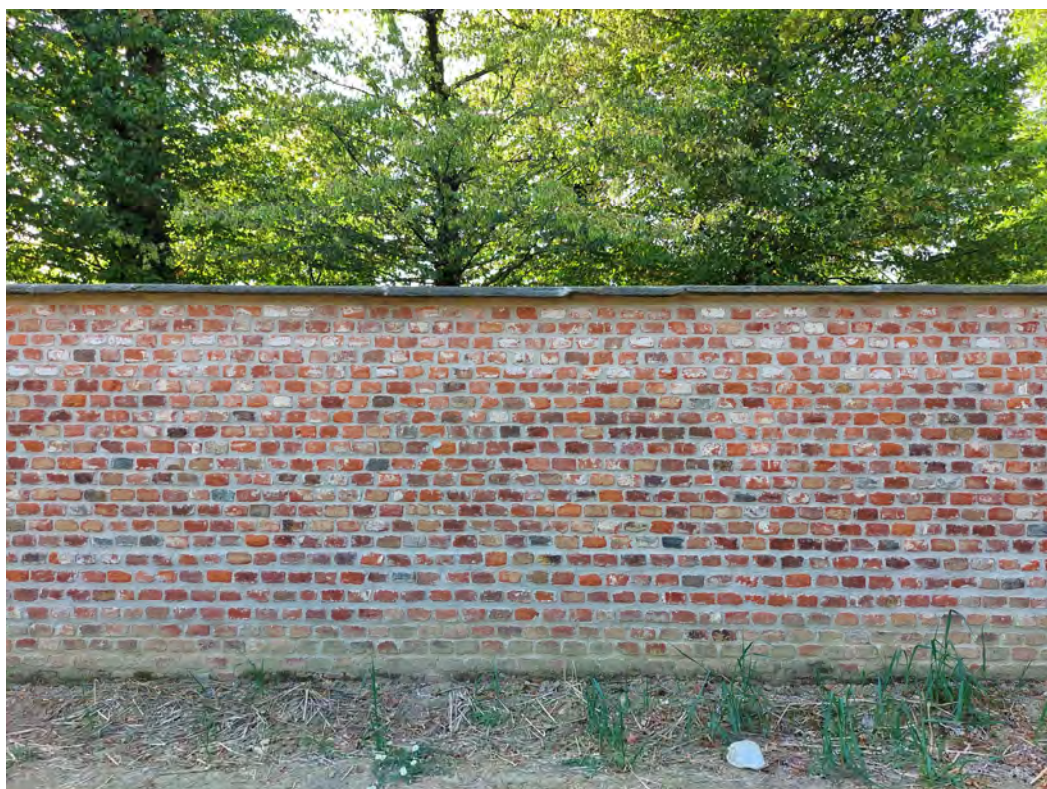
Tipologia 1 – Paramento murario in laterizio originale
