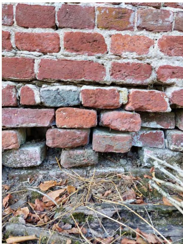
Fenomeni di degrado della muratura
