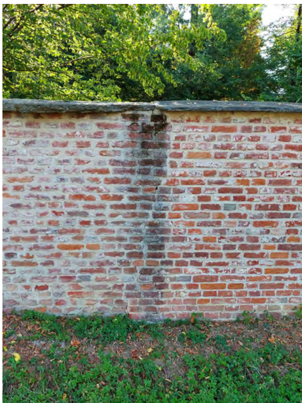
Fenomeni di degrado della muratura
